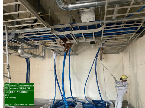
日本電設工業提供
