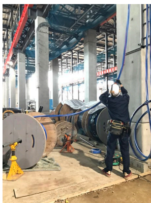
ケーブル繰り出し
