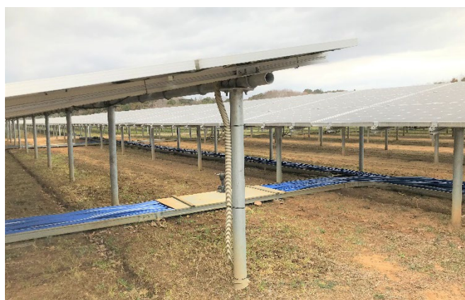
<パネル下配線（復旧後）>
