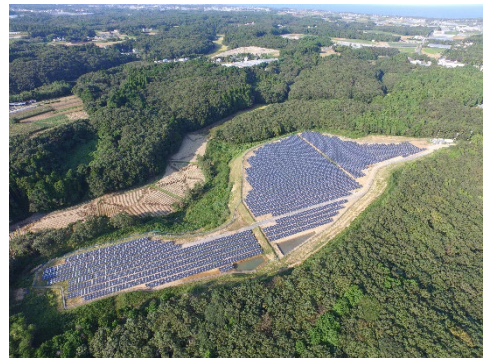
＜銚田市畑田第一発電所＞
