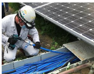
<トラフ内での接続処理>
