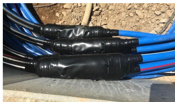
<Cu-CVD vs.AL-CVD 異種異径接続材料>
