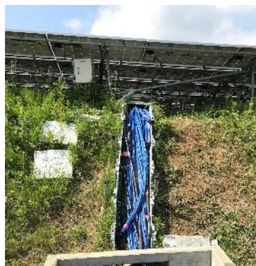
<らくらくアルミケーブル延線完了>
