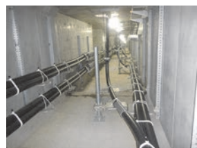
図 1 ケーブル延線・布設状況
