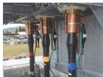
図 2 GIS 側終端接続部組立状況
