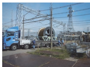
図 1 ケーブル延線・布設状況
