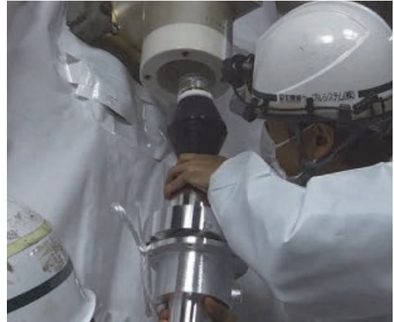
図4 高電圧ケーブルの現場での作業
