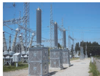
図 4 気中終端接続部組立状況
