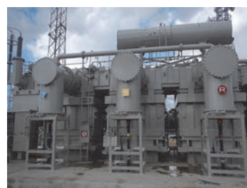
図 3 変圧器側終端接続部組立状況
