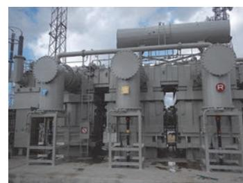
図3 変圧器側終端接続部組立状況
