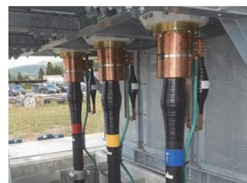
図2 GIS側終端接続部組立状況
