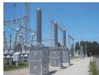
図4 気中終端接続部組立状況
