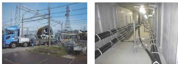
図1 ケーブル延線・布設状況
