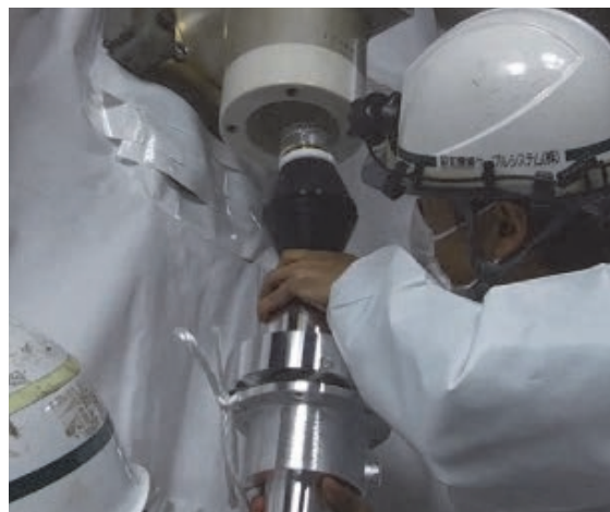
図4 高電圧ケーブルの現場での作業
