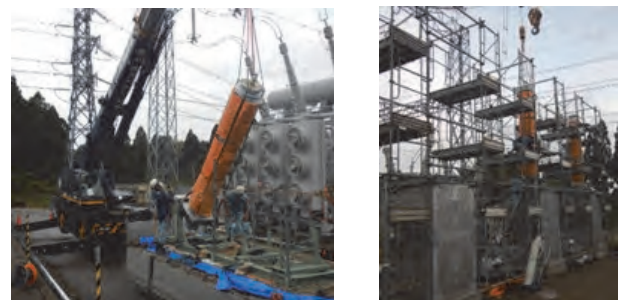
図 4 本体材料の据付状況
