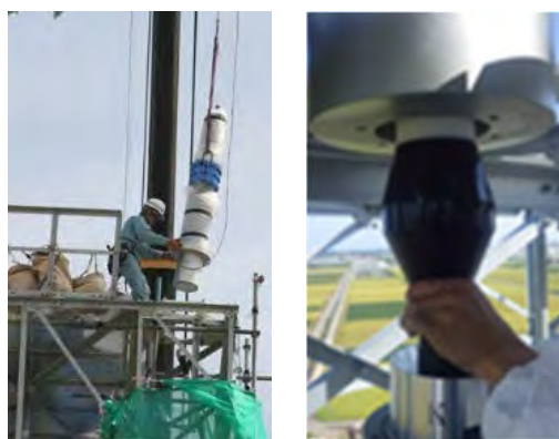
図5 施工例2（塔上取付）
