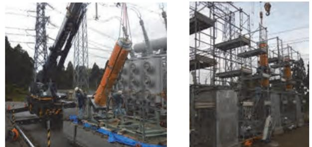
図 4 本体材料の据付状況
