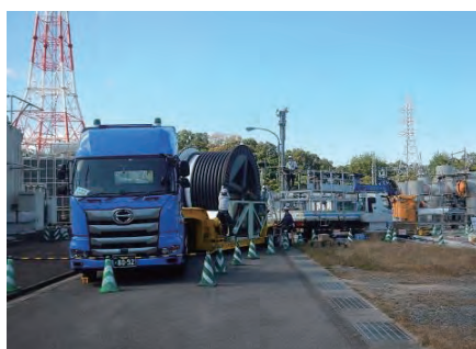
図1 ケーブル延線状況
