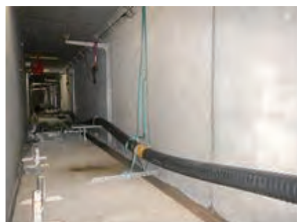
図2 ケーブル延線状況
