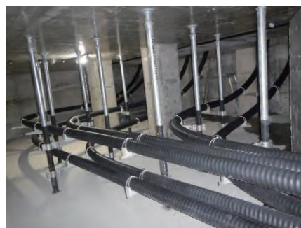
図3 ケーブル延線状況
