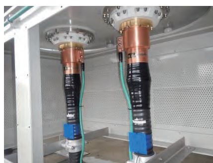
図4 終端接続箱組立状況
