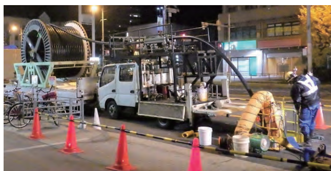
図 3 防蟻 CV ケーブル布設状況
