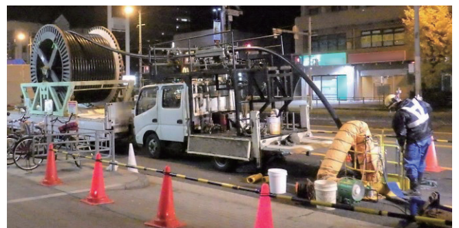
図 3 防蟻 CV ケーブル布設状況
