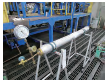
図3 補修実験後加圧放置（半年）状況
