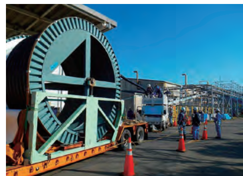
図9 BASF ジャパン株式会社殿戸塚工場 ケーブル敷設状況
