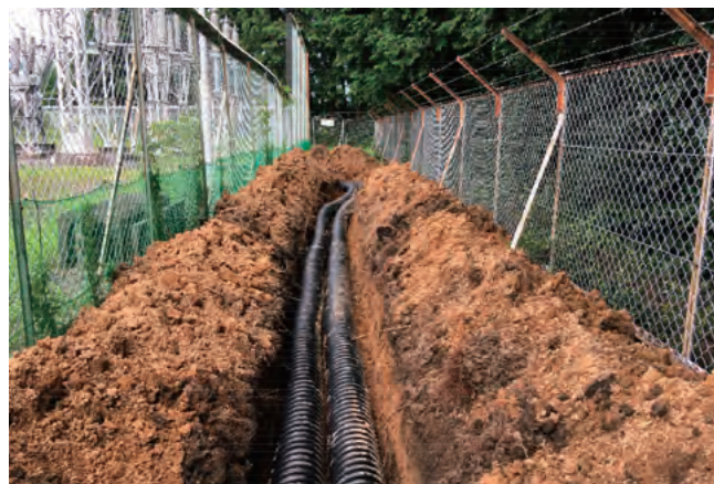
図5 6号幹線 (3.3 kV) 更新
