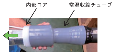
図3 常温収縮チューブ装着
