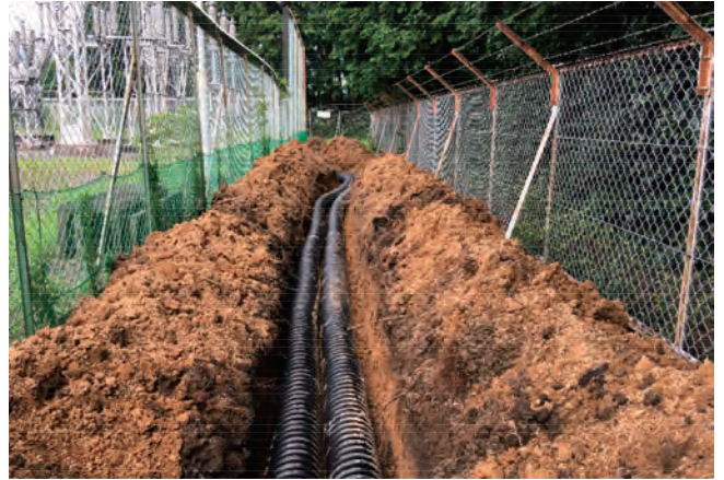
図5 6号幹線 (3.3 kV) 更新
