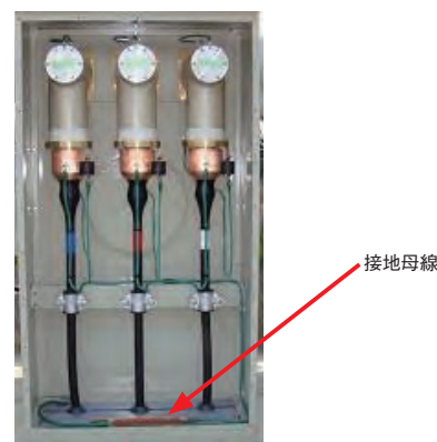
図2 準備済みの接地母線の例
