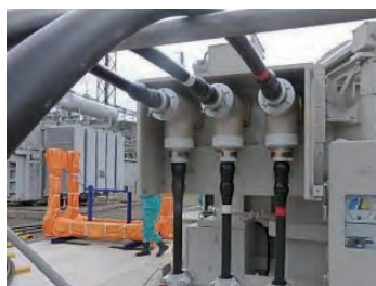
図4 110 kV 変圧器
