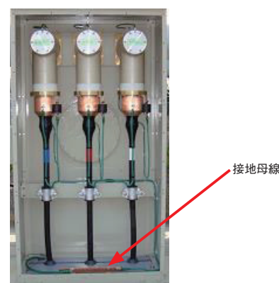
図2 準備済みの接地母線の例
