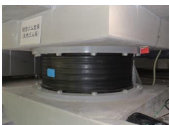
図 2 減災館に設置された積層ゴムアイソレータ
