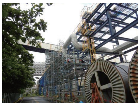
図4 ケーブル延線中状況
