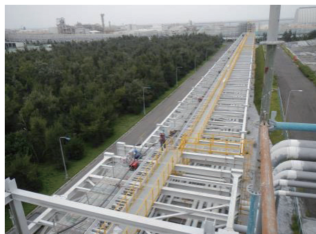
図3 ケーブル延線中状況
