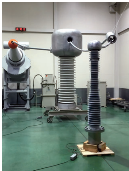
図6 部分放電試験
