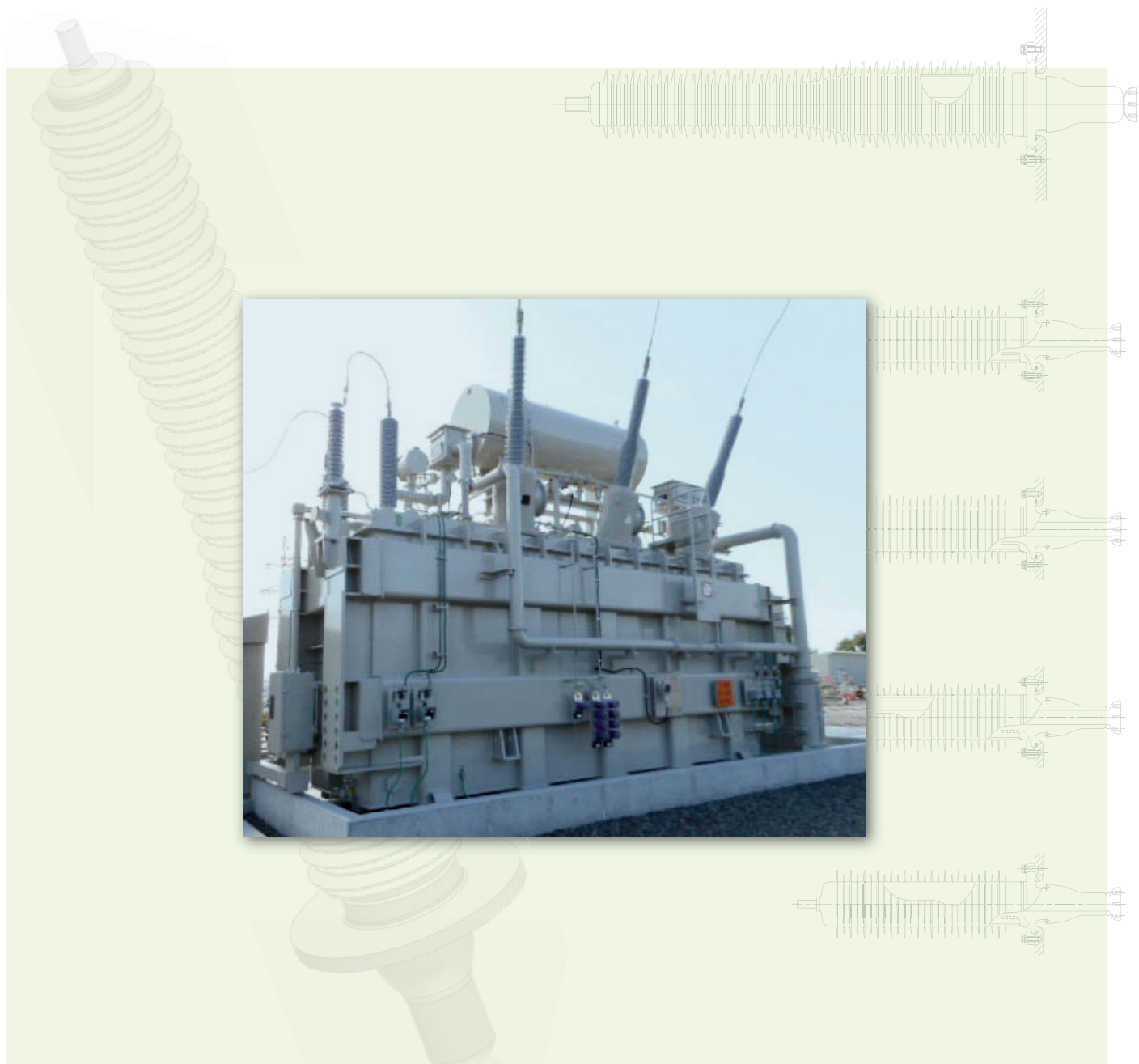
写真: 154kV機器用ダイレクトモールドブッシングを使用した変圧器 東北電力(株)殿ご使用 写真提供: 日立製作所(株)殿
