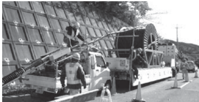
図 2 引入れ状況写真
