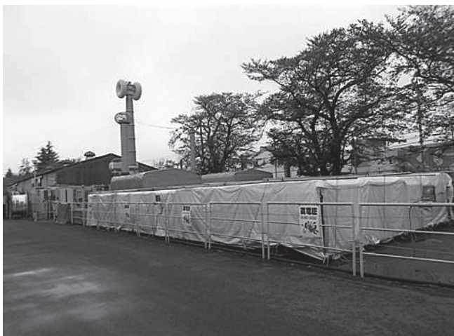
図8 長期課通電試験線路全体
