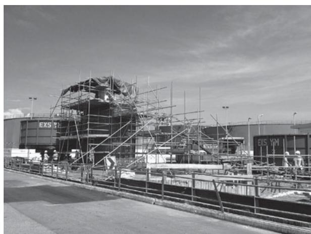
図5 長尺延線送り出し基地
