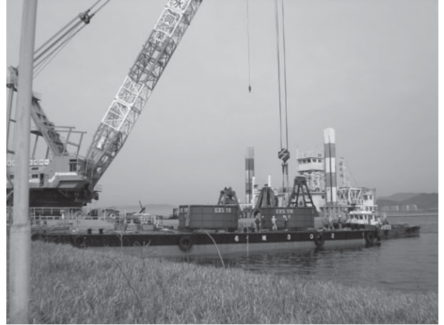
図4 ケーブル出荷風景 (エクシム 愛知工場)
