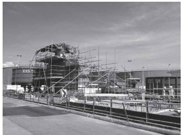
図5 長尺延線送り出し基地
