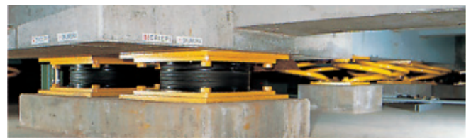
(株)奥村組 筑波研究所管理棟
