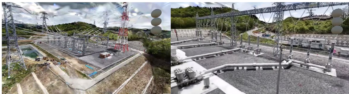
【3D データ化した超高压電気所設備の画像】
