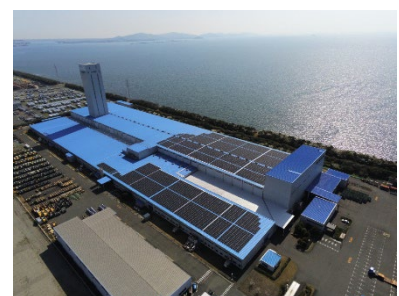
PPA モデルによる再エネ導入 愛知工場
