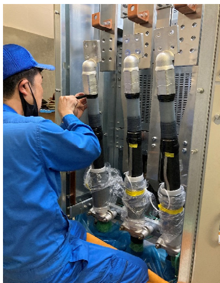
写真 1:終端接続部の取り付け作業
