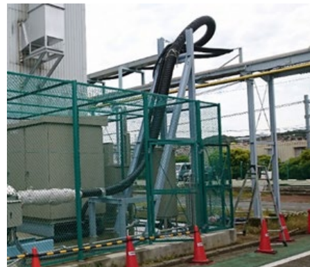
図7 屈曲部(90度、曲げ半径1.5m)敷設状況
