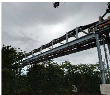
図6 ラック部(高さ5m)へのケーブル敷設状況
