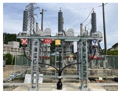
写真2 (ダイレクトモールド気中終端接続部)
