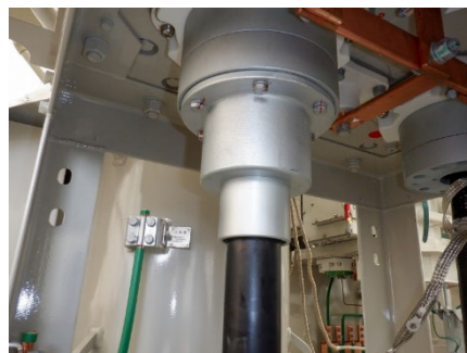
写真2: ケーブル挿入後
