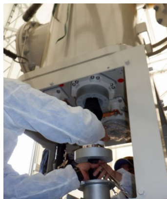
写真1: 両端末付ケーブル現地挿入作業
