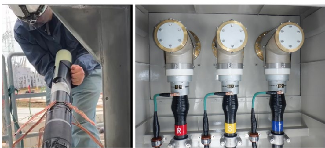
左：北陸電力送配電(株)加賀変電所に据え付けられる e-Cable®、右：154kV T 形終端接続部の据付状況
