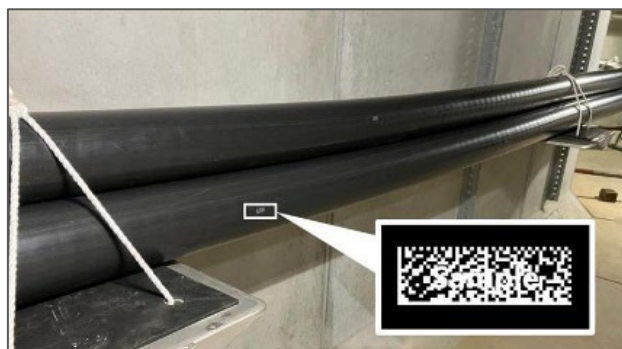
二次元コード付き電力ケーブルの印字状態
