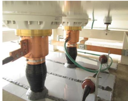
図 3. ケーブル接続後の状況 接続プラグは脱着が可能
