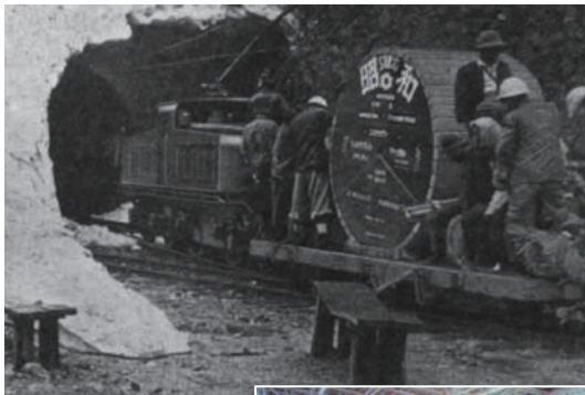
黒部川送電工事 (1956年撮影)
