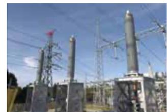
プラグインタイプ 超高圧275kV スマート気中終端接続部
