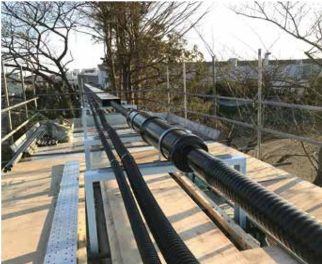
三相同軸超電導ケーブルシステム実証実験
