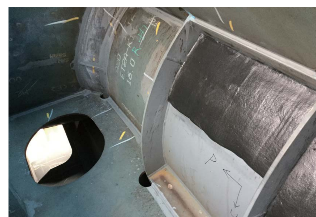
塗布作業 (曲面)
