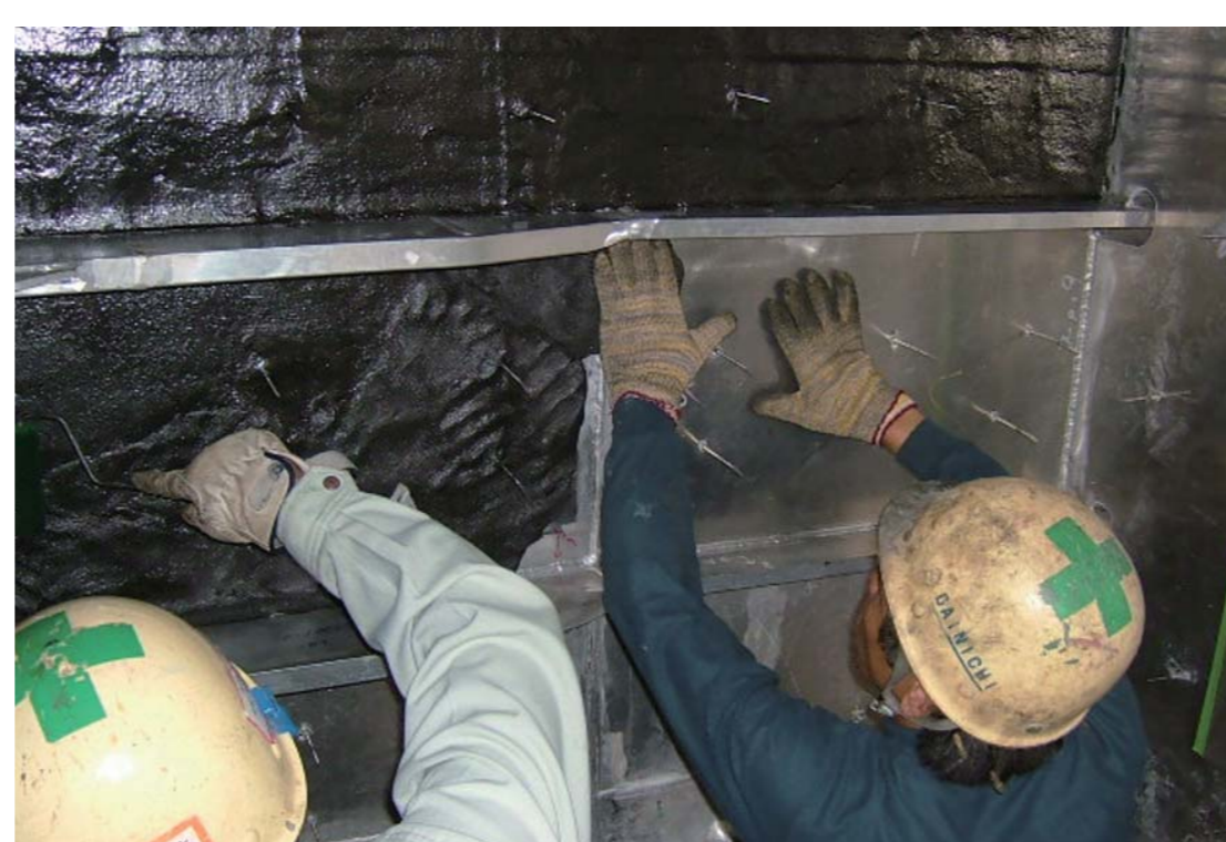
塗布作業 (壁面)
