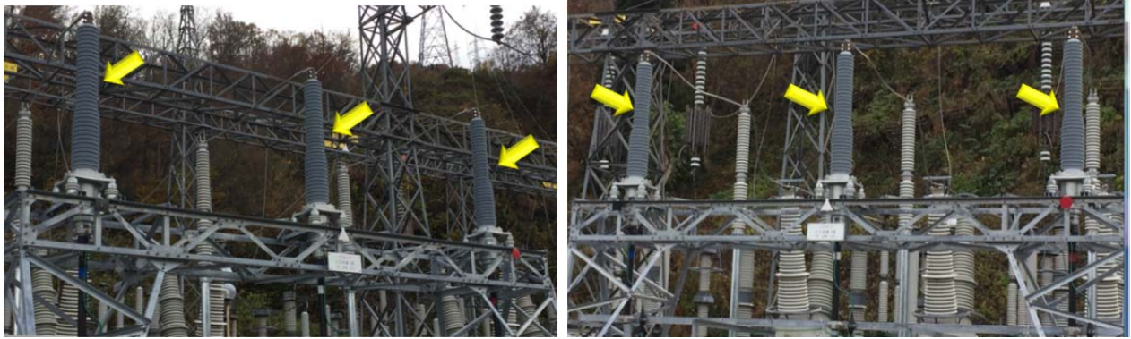
図1. 現地据付状況
