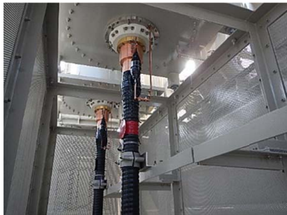
図 3. ケーブル接続後の状況
