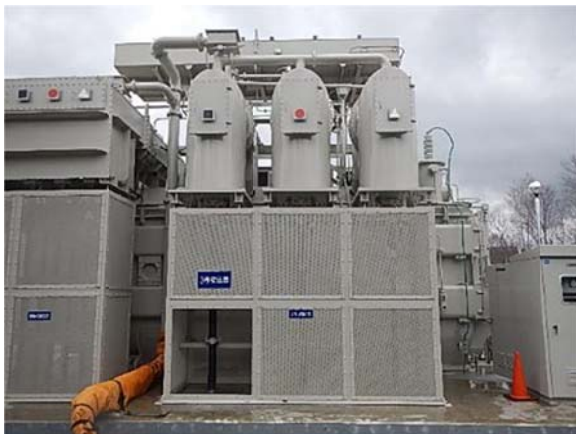
図 2. ケーブル接続後の変圧器外観
