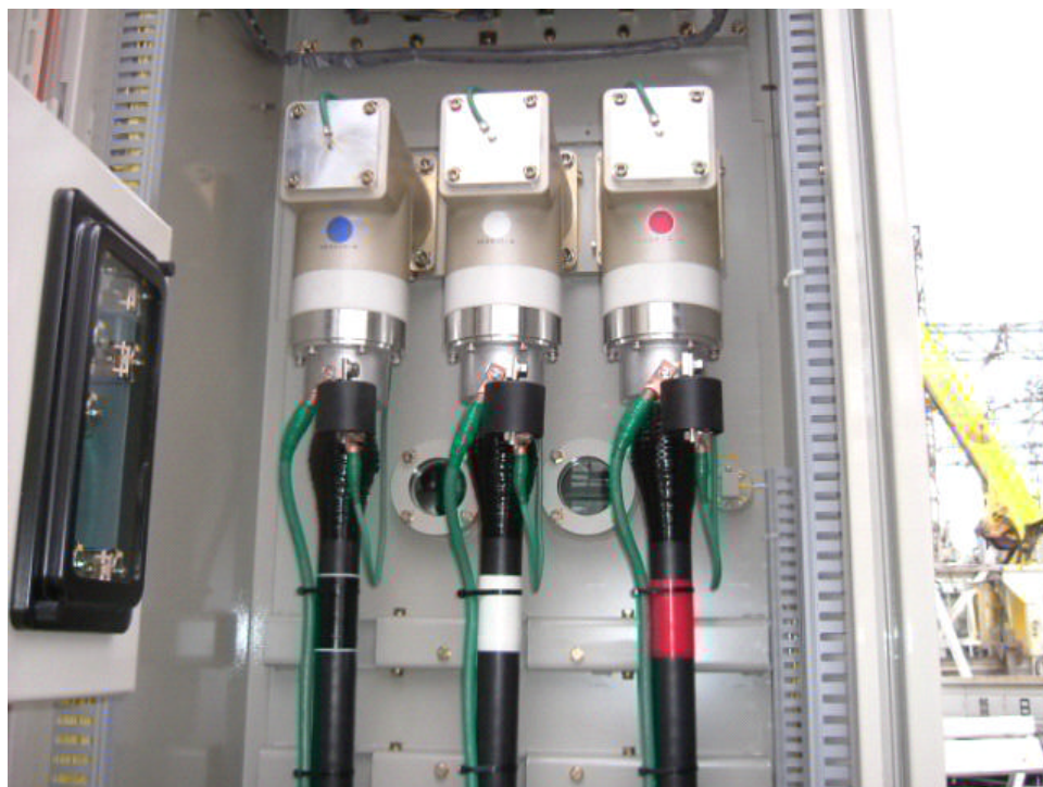
機器取付状態
