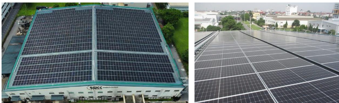
太陽光発電設備を導入した SVC の工場
