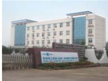
特変電工昭和(山東)電纜附件有限公司 (中国山東省新泰市)
