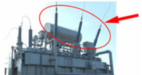
154kVダイレクトモールドブッシング適用例
