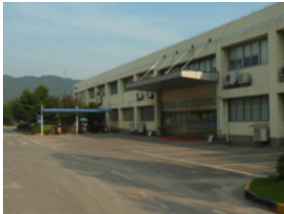
富通昭和線纜(杭州)有限公司 (中国浙江省杭州富陽地区)
