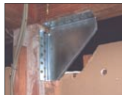
仕口ダンパー取付施工写真
