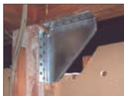
仕口ダンパー取付施工写真
