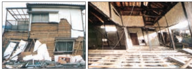
阪神・淡路大震災における木造建築物の地震被害 (出典：阪神・淡路大震災調査報告書 日本建築学会、阪神・淡路大震災と歴史的建造物 思文閣出版)
