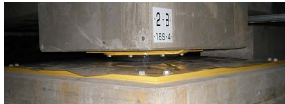
防塵カバー取付け例
